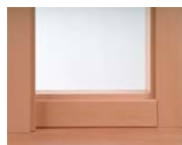
provedení bočního světlíku se spodním rámovým dílem
