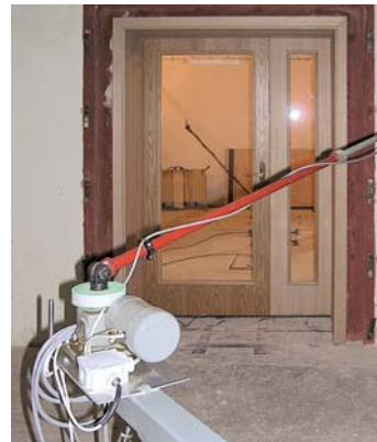
zkouška zvukově izolačních vlastností – dvoukřídlé prosklené dveře
